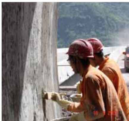
所有施工工人都接受了凯顿公司技术指导的上岗培训和产品实践操作
