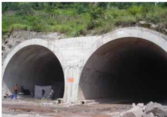
水麻高速公路延伸180多公里
