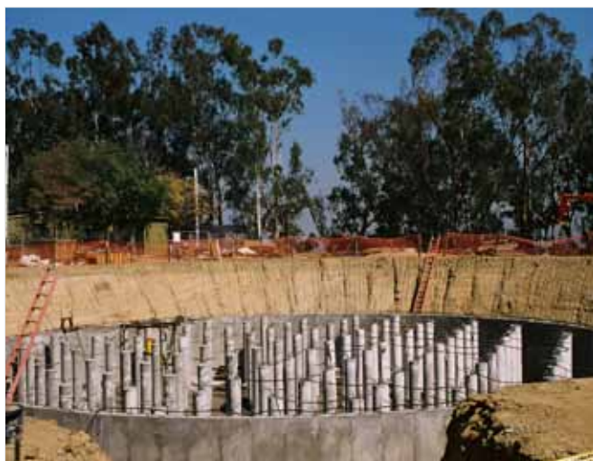
容积为 950立方米 (250,000) 加仑的蓄水池收集雨水来灌溉中心内的花园和绿植。
