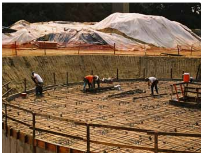
由于无法进行维修和保养，蓄水池在建筑伊始就要终身防水。
