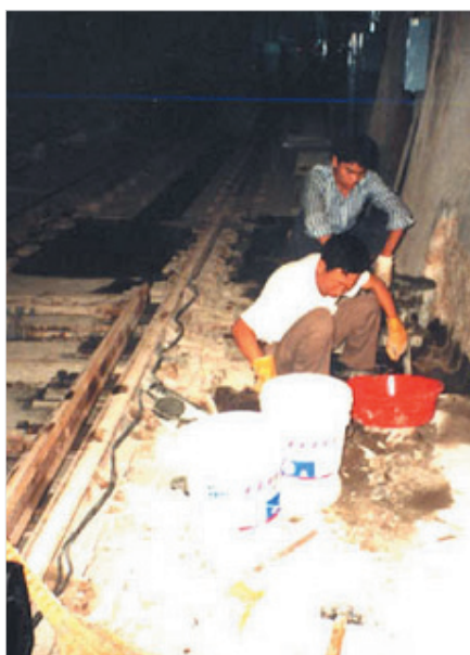
工人在现场修补隧道工程
