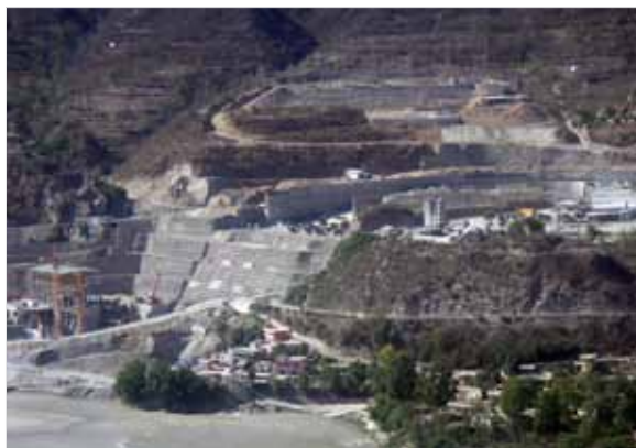
阿拉卡那达大坝工地现场
