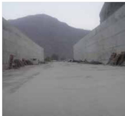
此大坝工程中, 共有约 1000 吨凯顿公司的防水系列产品被应用于数万吨的混凝土中。
