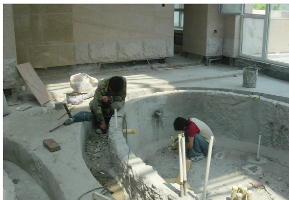
适用整体结晶产品施工的游泳池工地现场
